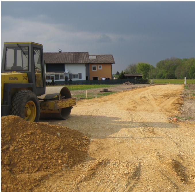
**Kurzbeschreibung:** Um eine neue Siedlung im Ortsteil Forchtenau aufzuschließen, werden eine Schmutzwasserkanalisation, welche in die ARA des RHV. Mittlere Antiesen einleitet, ein Reinwasserkanal, welcher nach Retention in die Antiesen entwässert, sowie eine Wasserleitung errichtet. Die benötigten Erschließungsstraßen werden in diesem Zuge ausgekoffert und mit Frostkoffer geschottert um eine Zufahrt für die künftigen Hochbauarbeiten zu ermöglichen.
